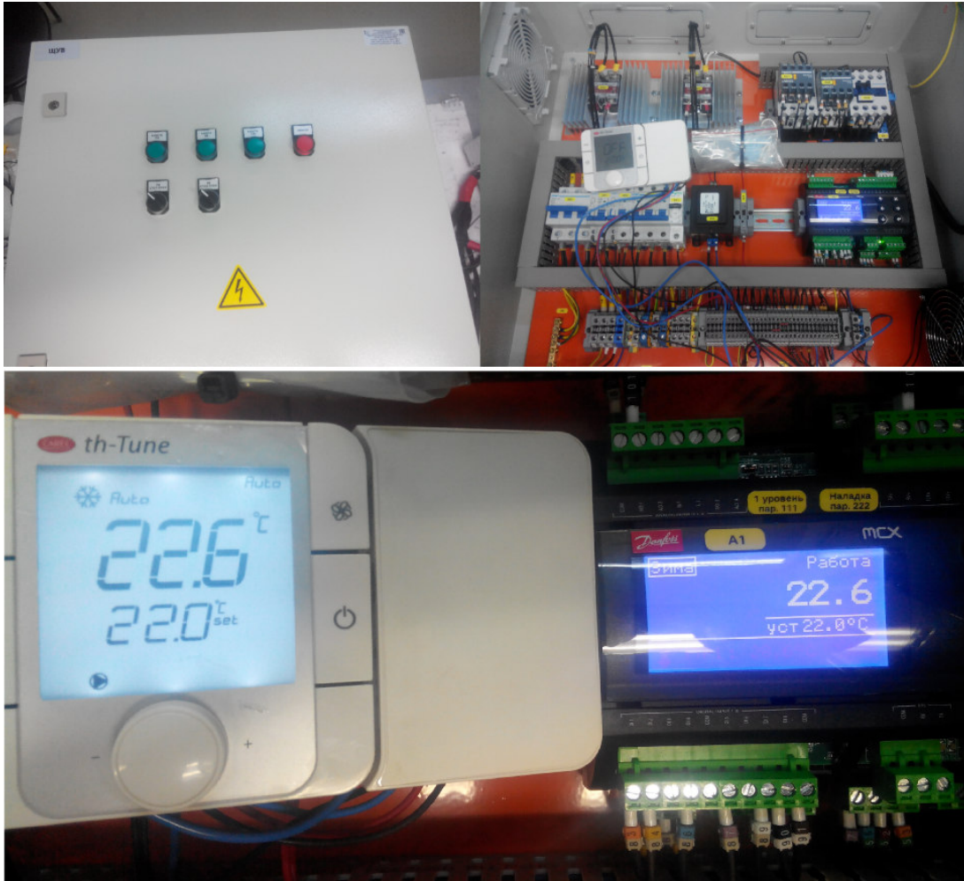
Рисунок 1.10. ША-КП-П135-В111-Эп17-ДЗ-М IP54 УХЛ4 ThTune-Н-24VAW0.
