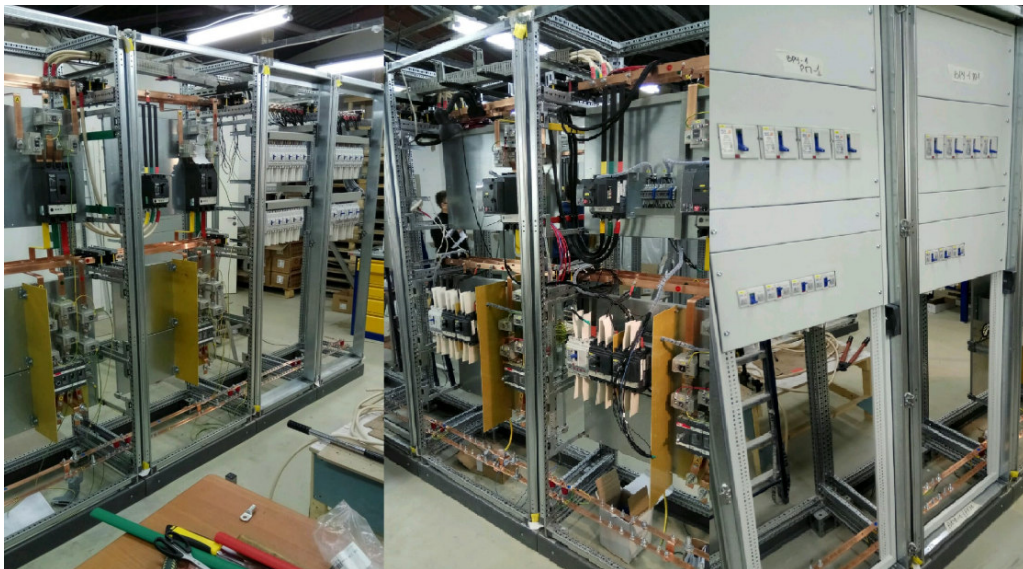
Рисунок 1.1. ВРУ-1 630А. Процесс сборки.
