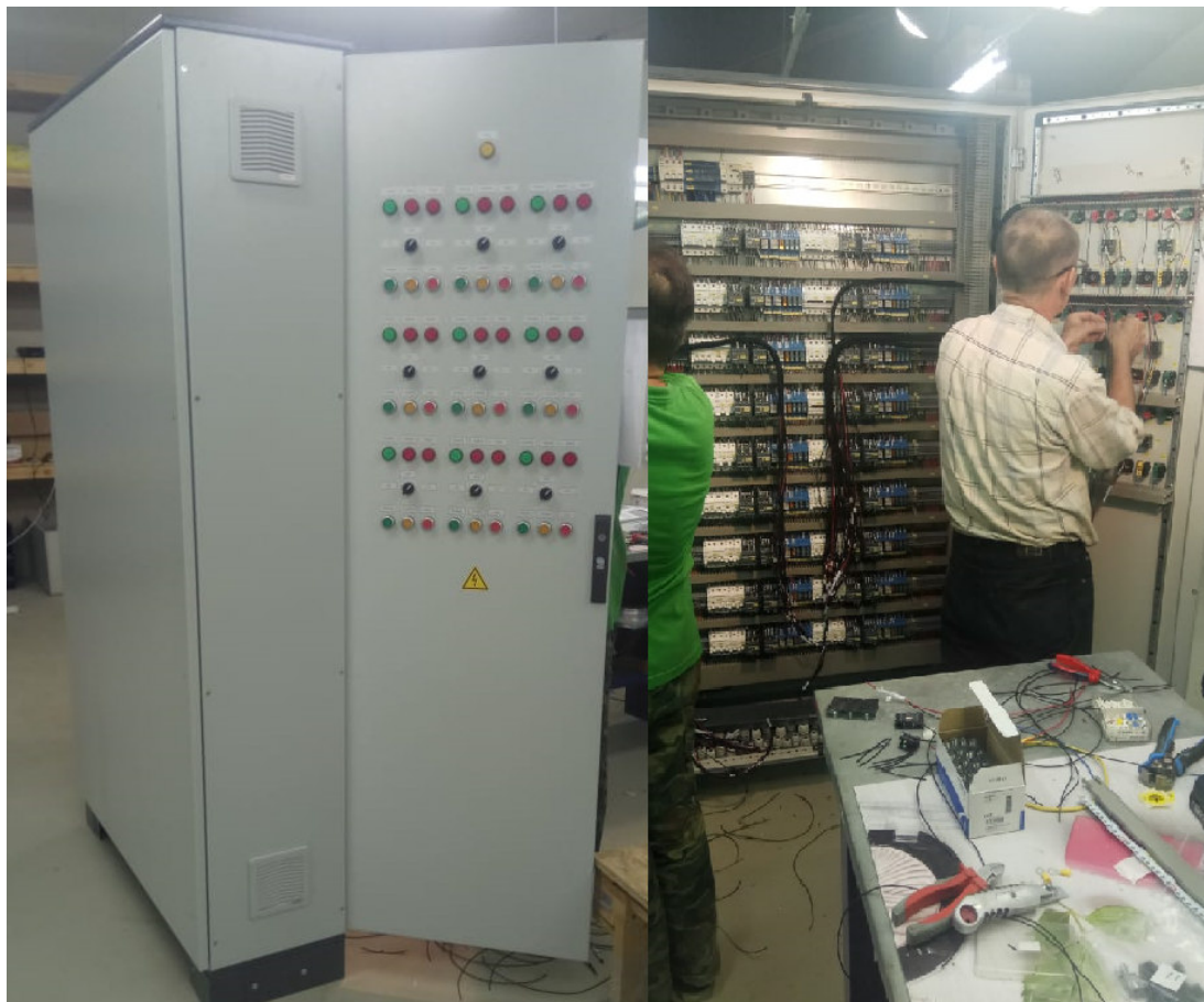
Рисунок 1.15. ШУ ВК. Процесс сборки.
