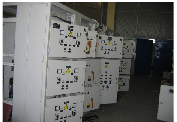
Рисунок 2.11. РУНН со схемой АВР на 4 ввода + 2 ввода ДЭС + секционный выключатель.
