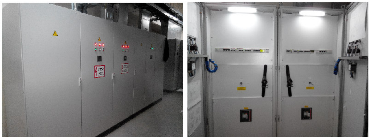
Рисунок 2.13. ВРУ-3 1250А с реализацией схемы АВР на контроллере Zelio с моторизованными реверсивными выключателями нагрузки OT1250E03CM.
