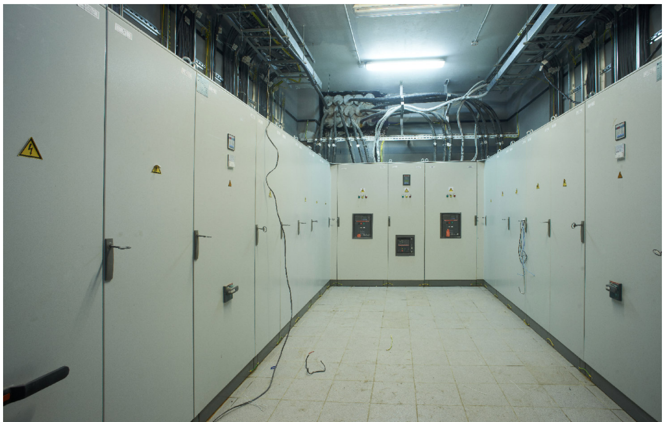
Рисунок 2.14. ГРЦ 3200А на комплектующих фирмы АВВ.
