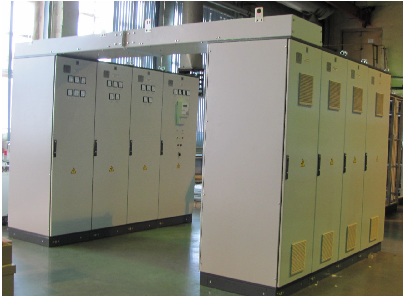
Рисунок 2.15. КТП-6 РУ-0,4кВ со степенью секционирования 2А.
