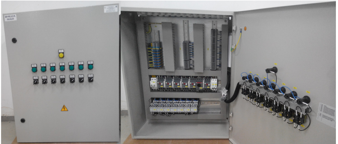
Рисунок 1.2. ША-КП-6хВМ102-ВМ103-М IP31 УХЛ3 (КнП).
