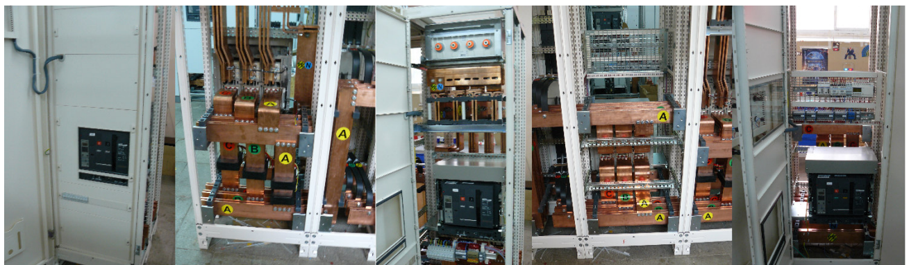
Рисунок 2.8. ГРЩ 3200А в сертифицированном сборочном производстве по Golden Club Prisma.
